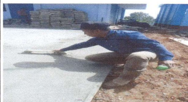
Foto 4: Reparación de plancha de concreto de patio.
