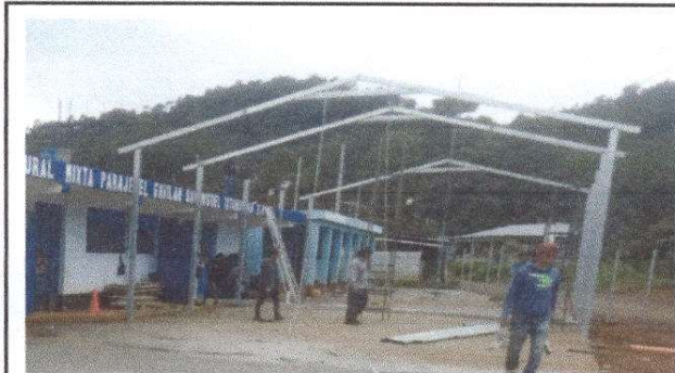
Foto 1: Sustitución de lamina por lamina troquelada aluzinc calibre 26, sustitución de estructura de soporte de metal por metal.
