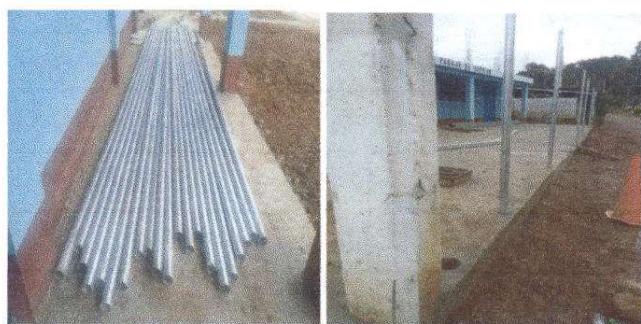
Foto 5: Reparación de tubo HG y malla galvanizada.
