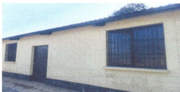
Foto 3: Fabricación e instalación de de ventana de metal.
