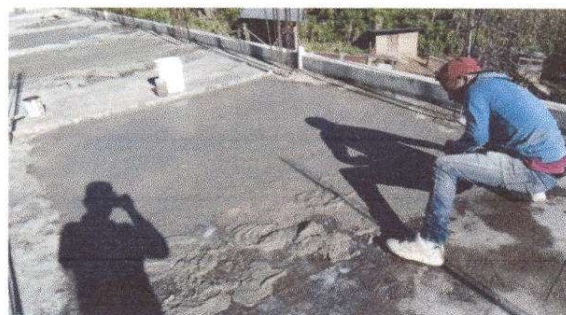
Foto 2: Reparación de pañuelos.
